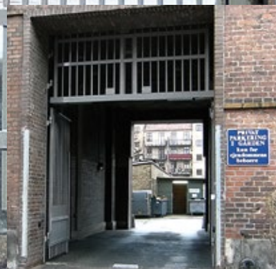
Begge åbne for renovation
