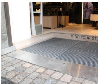
Plant gulv, klar til på-/afkørsel
