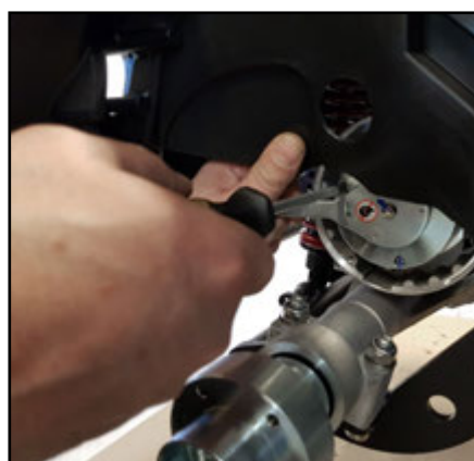
Afmonter magnetbremsen med de 3 skruer. De har alle fået locktite ved montage.
