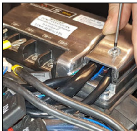
Afdækningen skrues fast.
