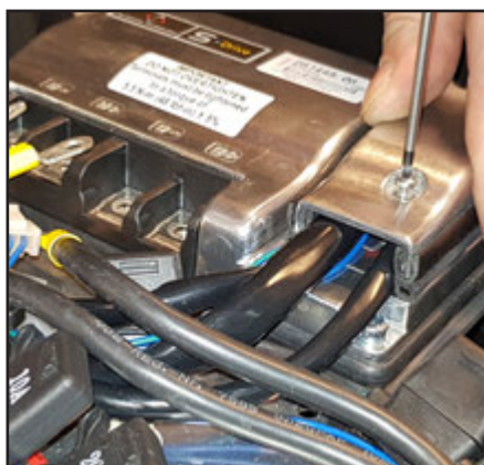
Afdækningen skrues fast.
