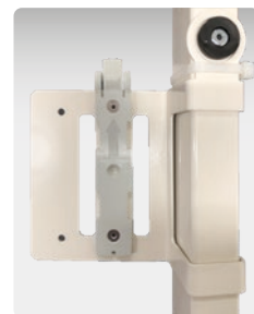
Monteringsbeslag med klips påsat sort afstandsstykke og fastspændt med strips.
